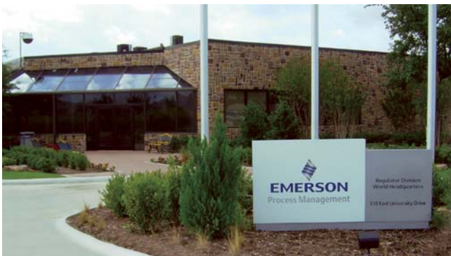
Oficinas centrales de la División de reguladores de Emerson Process Management, en McKinney, Texas.
